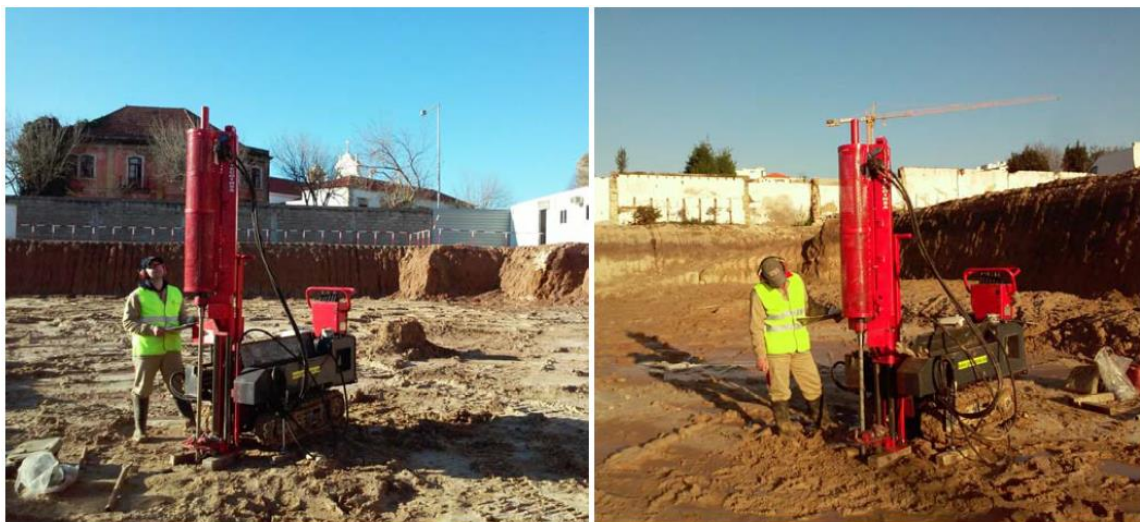
Figura 7 – Equipamento utilizado na realização dos ensaios DPH
